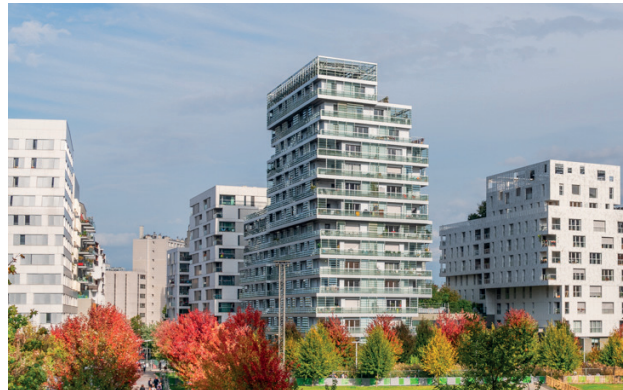
Sprongen in de gevel
