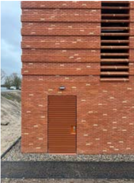
Deur technische ruimte
