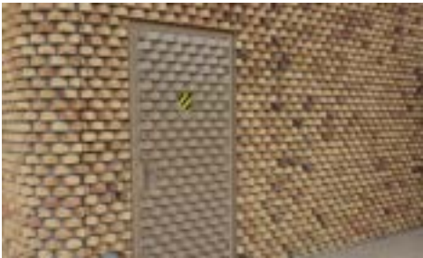
Deur technische ruimte
